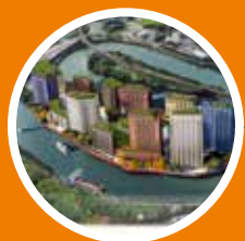
Energetické středisko, Velká Británie
